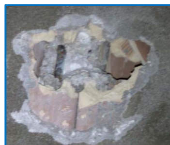
Saggio per il rilievo diretto delle barre di armatura
