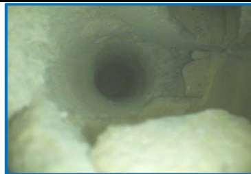
E2-2: Scatto eseguito a circa 5 cm da inizio foro: fine laterizio forato ed inizio calcestruzzo.
