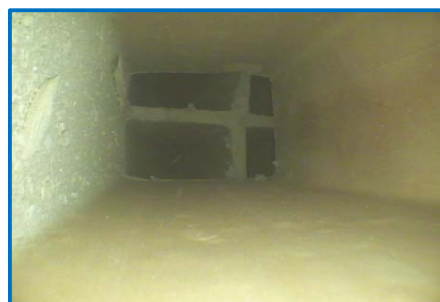
E3-2: Scatto eseguito a circa 10 cm da inizio foro: laterizio forato.
