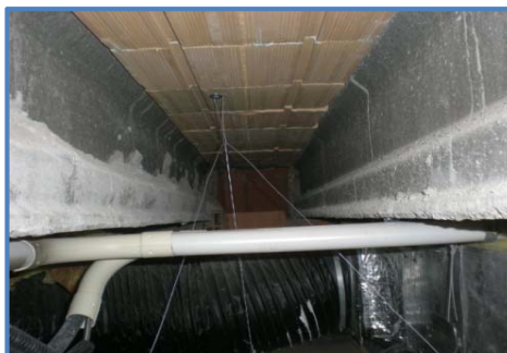
E1-2: Scatto eseguito a circa 20 cm da inizio foro: fine laterizio forato ed inizio soletta in calcestruzzo.
