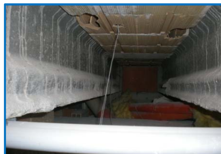
E2-2: Scatto eseguito a circa 5 cm da inizio foro: fine laterizio forato ed inizio calcestruzzo.
